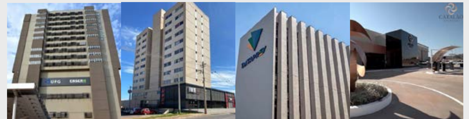
Construção do Hospital das Clínicas da Universidade Federal de Goiás
